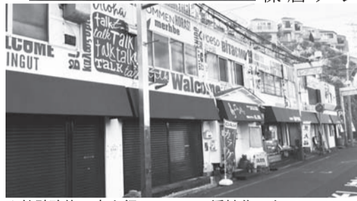
▲外壁改修工事をを行い、エリア活性化にも
